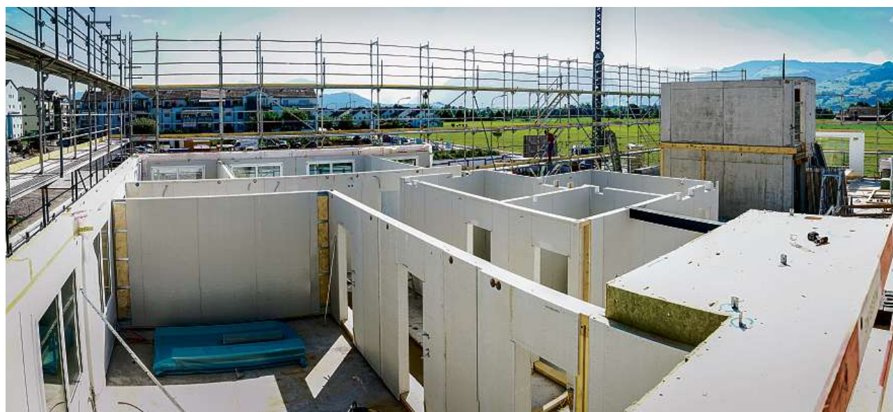
Bald fertig: Auf den Fundamenten des Wohnheims werden demnächst die Obergeschosse aus Holz angebracht.
