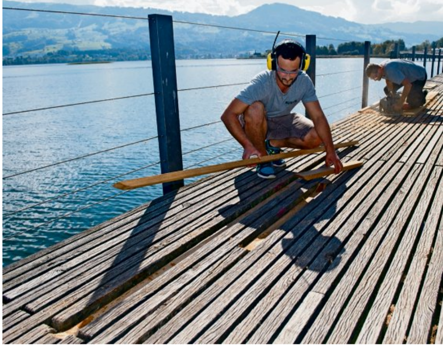
Die morschen Lamellen wurden ausgefräst, die neuen liegen bereit.
