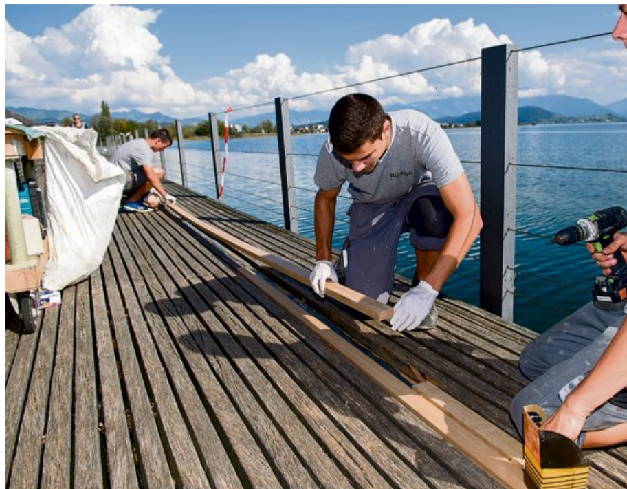
Die neuen Lamellen werden millimetergenau in die ausgefrästen Stellen hinein geleimt.
