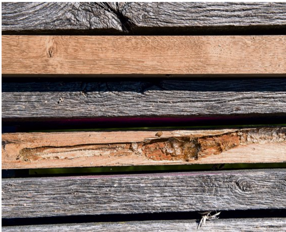
Der Eichenwirling, ein Pilz, hat sich zentimetertief ins Holz gebohrt.
